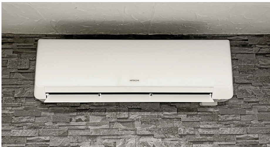
An eine Außeneinheit wurden drei Design-Wandgeräte und ein Yutampo-Wasserspeicher angeschlossen
